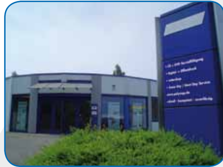
Tempelhofer Straße 9, Aachen
